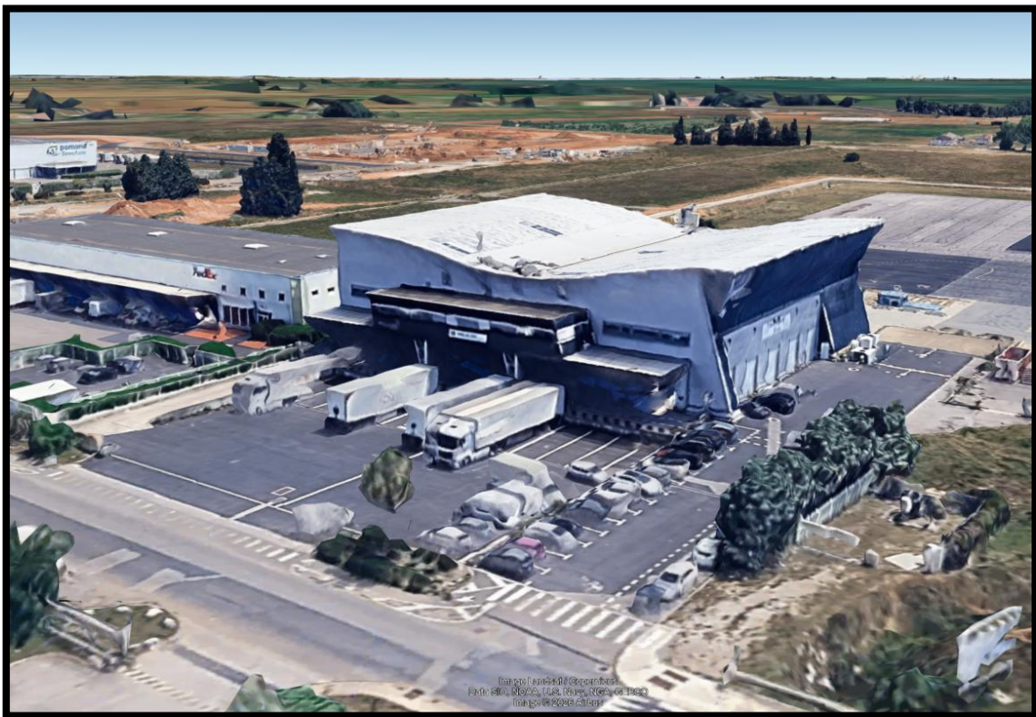
Vue 3D Google Earth façade ouest
